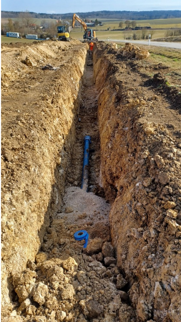
Leitungsgraben mit der neu verlegten Wasserleitung
