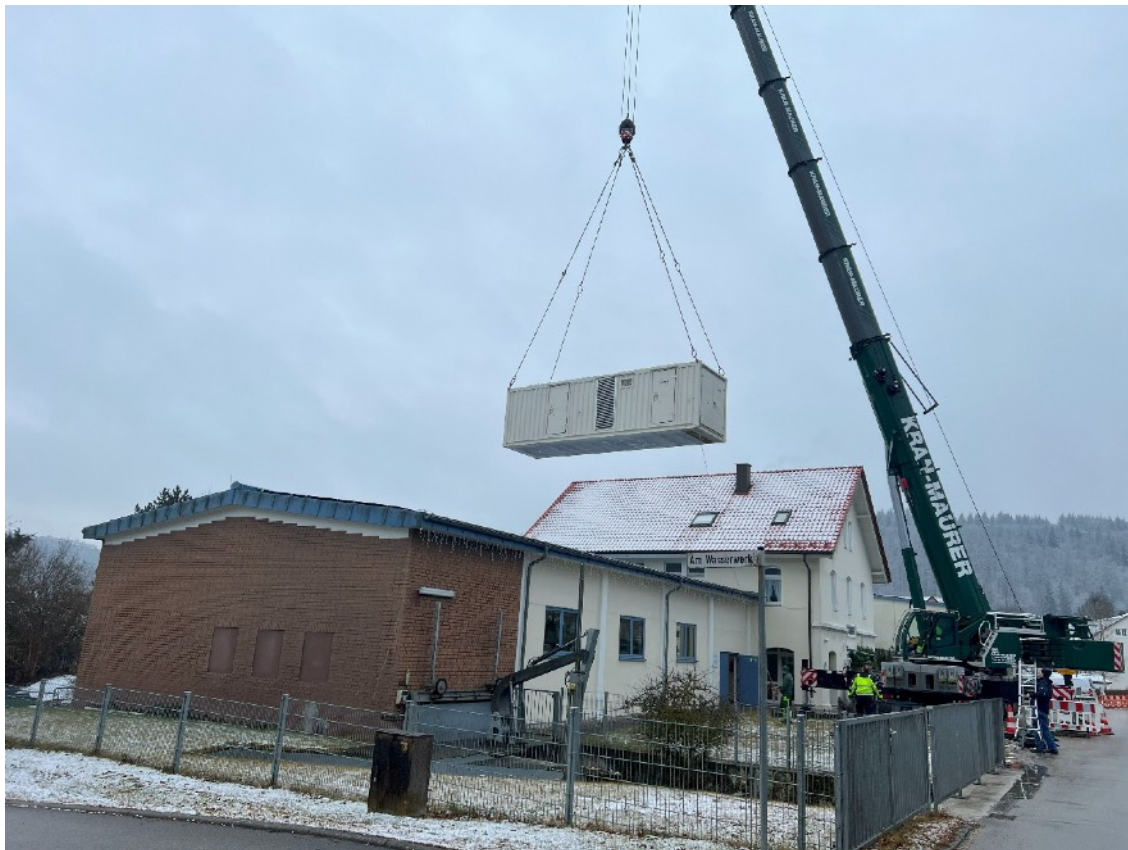
Anlieferung und Montage des Notstromaggregats im Februar 2025 mittels 5-Achsen 230-Tonnen-Kran
